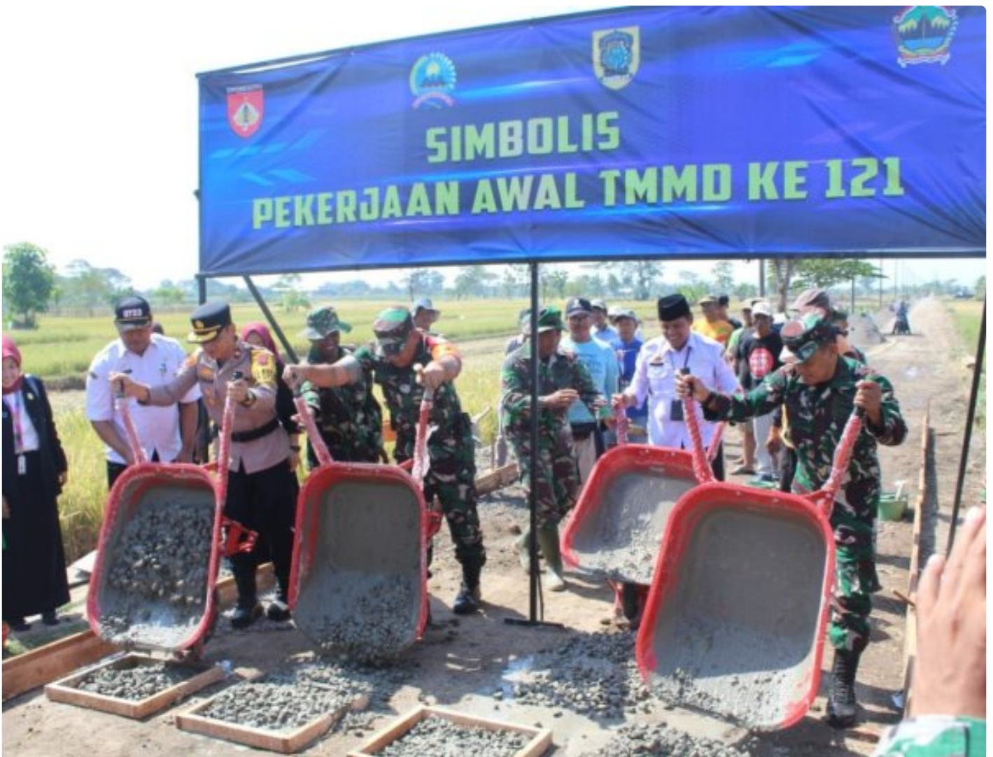
Pengecoran Perdana TMMD Reg 121 dilakukan Forkopimda Klaten
